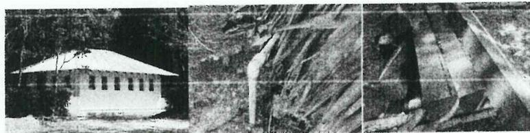
Elevación con estructura de madera, de sistema de tinacos de almacenamiento de agua, de manera que el agua llegue a los servicios sanitarios
